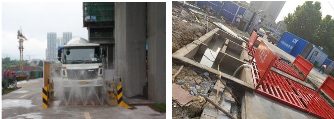
图 6.1-2 施工车辆冲洗设施及车辆冲洗废水处理设施
