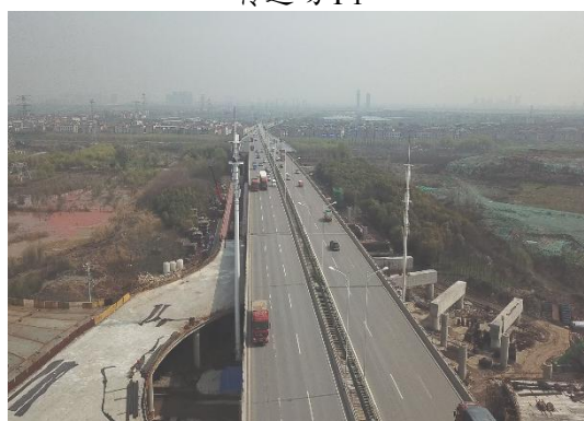
施工生产生活区 1 (右侧空地)
