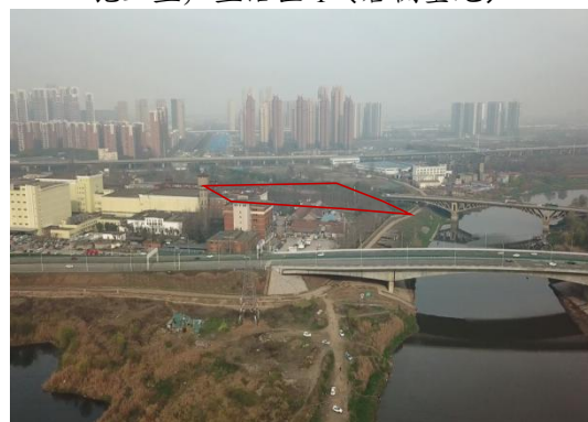
施工生产生活区 3
